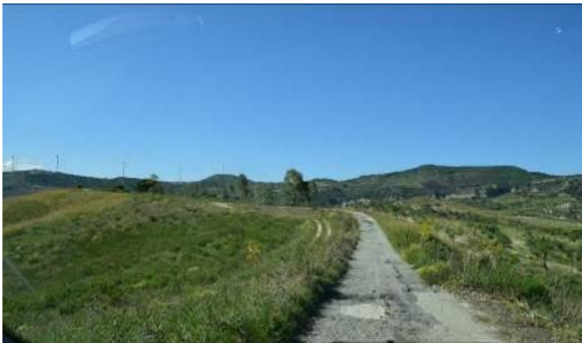
Figura 3.3.2/L - Viabilità di accesso alla posizione della torre T03
