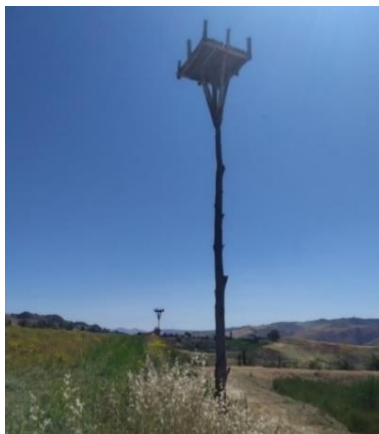
Figura 11.2.2/A - Esempio di palo in legno infisso al suolo per cicogna bianca
