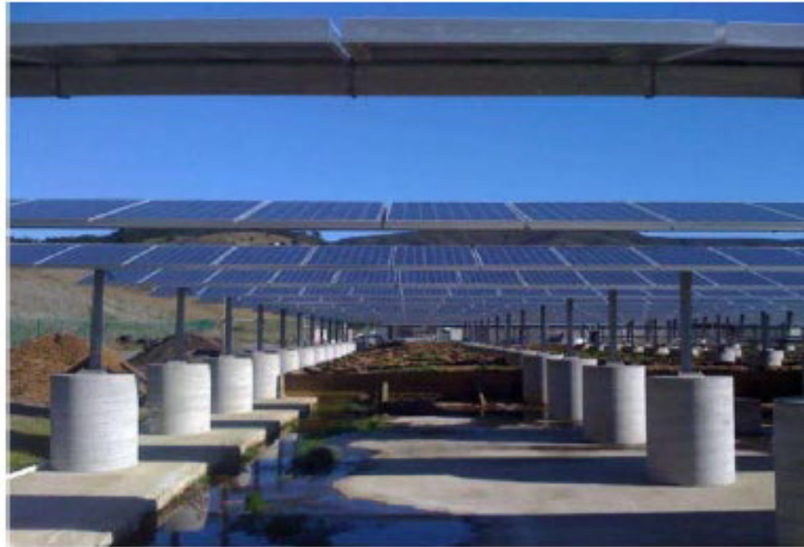
Figura 18 - Esempio di impianto fotovoltaico con fondazioni ottenute mediante perforazione del terreno e successiva creazione del palo di fondazione con getto di cemento.
