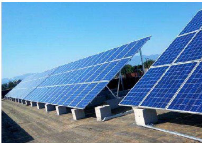
Figura 19 - Esempio di impianto fotovoltaico con fondazioni formate da zavorre costituite da plinti in cemento
