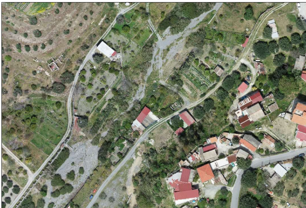
Vegetazione in alveo – Argini crollati
