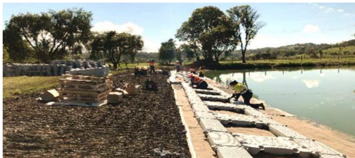
Assemblaggio e scorrimento delle strutture galleggianti con sopra installato il modulo fotovoltaico
