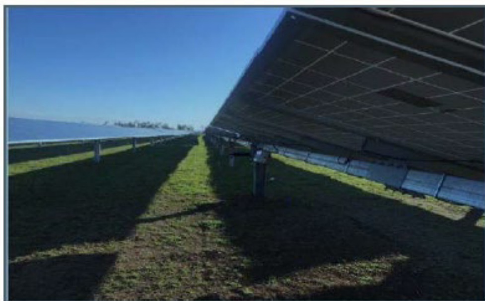
Figura 16 - Esempio di impianto fotovoltaico realizzato con supporti costituiti da pali in acciaio infissi direttamente nel terreno. Gli impatti sul suolo sottostante risultano essere minimizzati.
