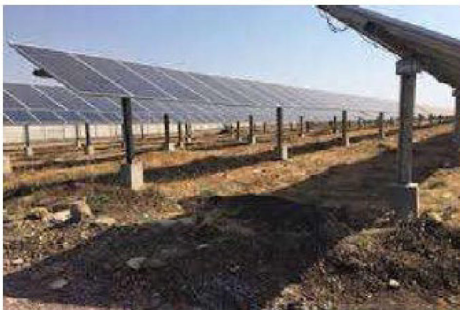
Figura 17 - Esempio di impianto fotovoltaico con fondazioni ottenute mediante perforazione del terreno e successiva creazione del palo di fondazione con getto di cemento.
