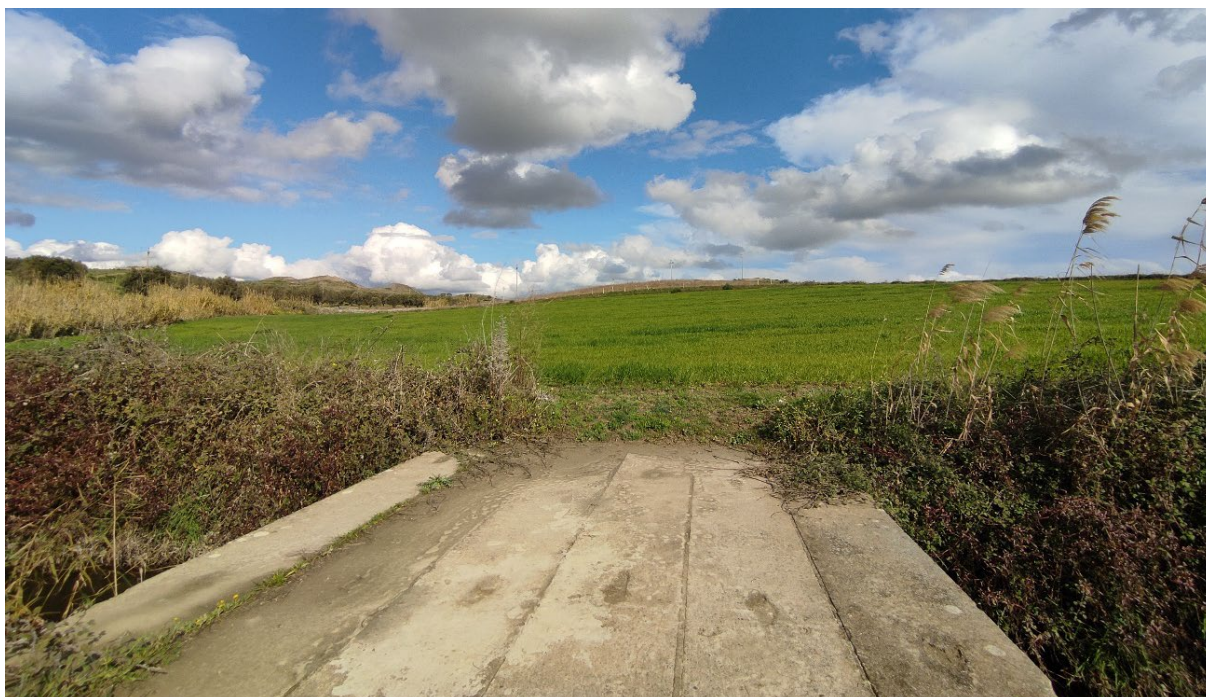
Figura 6 - Struttura che consente attraversamento del canale
