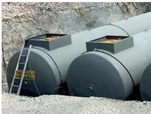
Figura 42 – Serbatoi per oli minerali interrati, a doppia camicia e con sistema di verifica continua di assenza di fuoriuscite (Immagine Illustrativa)
