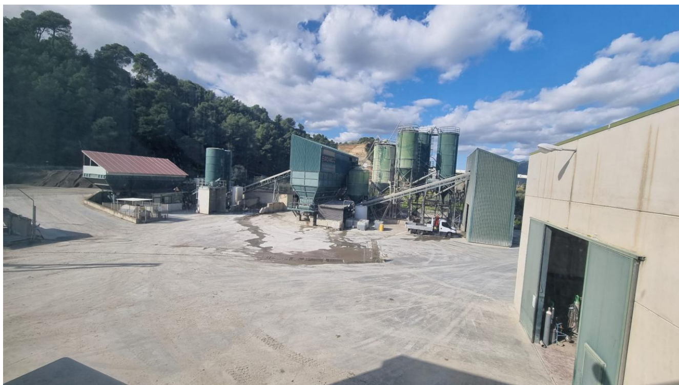
Figura 9_Foto impianto di Calcestruzzo
