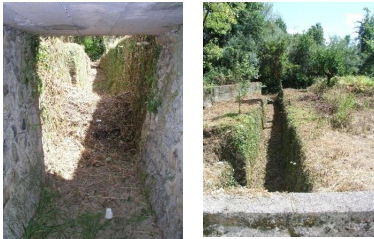
Figura 21 – Opera di restituzione esistente dell'impianto: vista della sezione del vano di raccolta in corrispondenza al tratto del canale coperto (a sinistra), e dello sviluppo del rimanente tracciato a cielo aperto (a destra)
