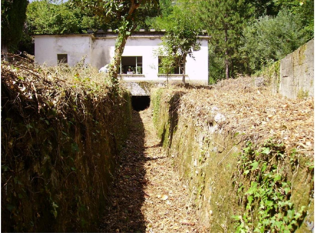
Figura 83 – Foto estratta dalla Tavola T10 (foto n.6) allegata al progetto, rappresentante il canale di restituzione all'alveo che parte dall'edificio centrale. Interventi di ripristino non determineranno tagli a carico della vegetazione arborea, ma solo decespugliamento interno alla sezione.
