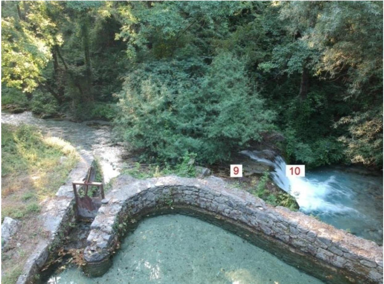
Figura 46 – Foto estratta dalla Relazione Tecnica Generale allegata al Progetto Definitivo, raffigurante il punto della sponda di destra fluviale della traversa dove verrà realizzato il setto di rilascio del deflusso ecologico (9), e della posizione della scala di risalita della fauna ittica (10).
