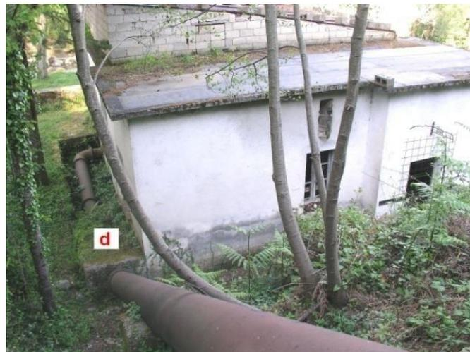
Figura 18 – Condotta forzata esistente dell'impianto: vista del blocco di ancoraggio attiguo all'edificio centrale (d)
