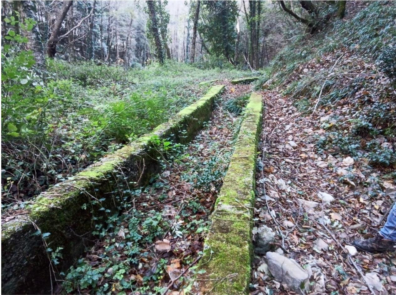
Figura 47 – Cono fotografico 52: Tratto iniziale del canale di derivazione; l'interno della sezione sarà soggetto a ripulitura e decespugliamento. Non si riscontra alcuna presenza di specie di interesse naturalistico. Gli interventi di ripristino sul canale non comporteranno, in questo primo tratto, il taglio della vegetazione arborea. Nessuna interferenza.
