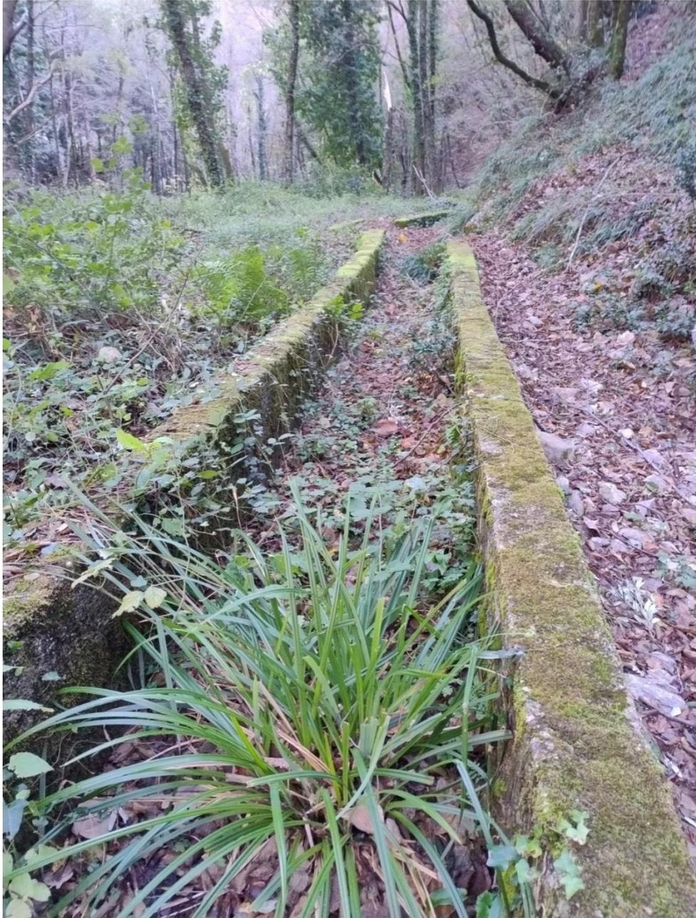
Figura 48 – Cono fotografico 13: Tratto iniziale del canale di derivazione; l'interno della sezione sarà soggetto a ripulitura e decespugliamento. In primo piano nella foto si nota *Carex* sp. Non si riscontra alcuna presenza di specie di interesse naturalistico. Gli interventi di ripristino sul canale non comporteranno, in questo primo tratto, il taglio della vegetazione arborea.
