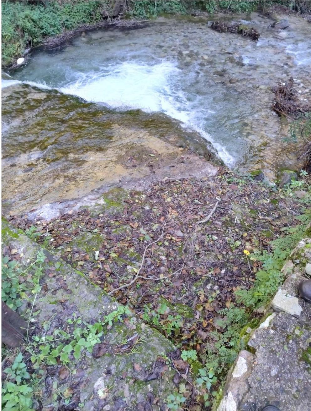
Figura 45 – Cono fotografico 12: **Visuale del lato di destra fluviale della traversa in alveo dove verrà realizzata la sede rettangolare del setto di rilascio della portata di deflusso ecologico DE, comunicante con la scala di risalita della fauna ittica in progetto** (per dettagli progettuali si veda la Tavola T5.B Rev. 2, ai punti 9 DE e 10 DE, allegata al progetto).
