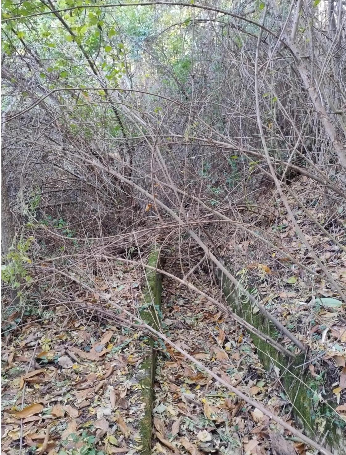
Figura 72 – Cono fotografico 34a: Foto scattata una volta raggiunto il tratto finale del canale di derivazione. Necessaria la ripulitura del canale con taglio di polloni appartenenti a specie arbustive o giovani individui arborei ai margini.
