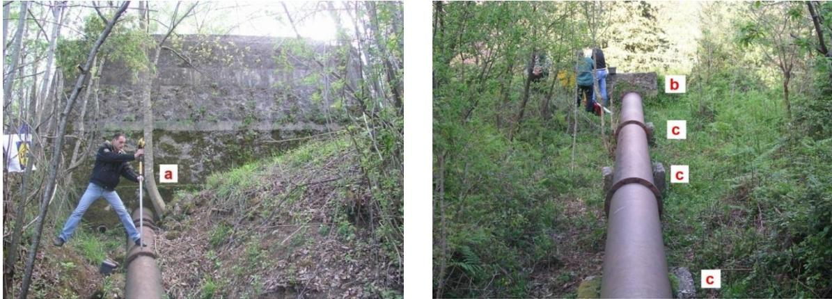
Figura 17 – Condotta forzata esistente dell'impianto: vista del tratto iniziale inghisato nel muro di valle della vasca (a); di uno dei blocchi di ancoraggio (b), e delle selle di appoggio (c)
