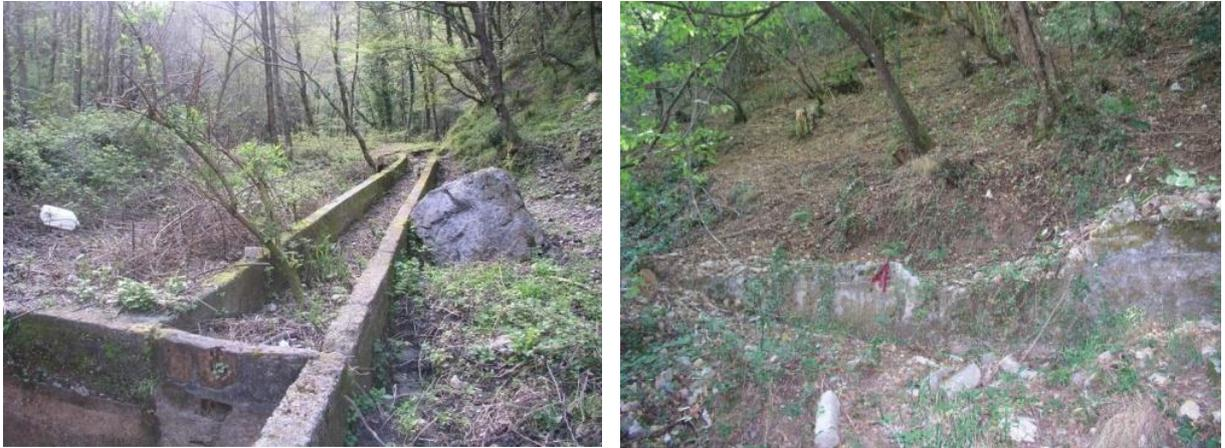
Figura 7 – Canale di derivazione tra i picchetti 1 - 8: vista del tratto iniziale in uscita dalla vasca di sedimentazione (a SX), e dello sviluppo (a DX)
