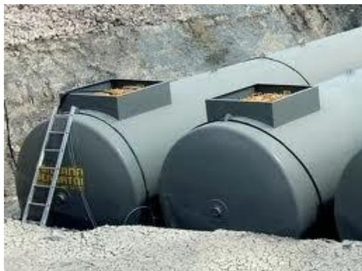
Figura 42 – Serbatoi per oli minerali interrati, a doppia camicia e con sistema di verifica continua di assenza di fuoriuscite
