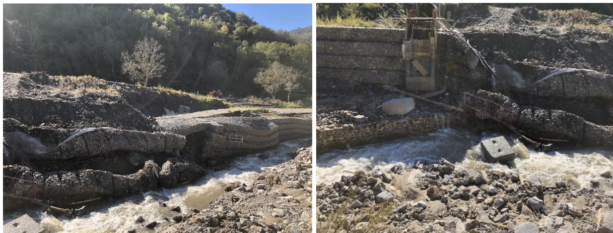
Figura 3.2 –Scalzamento e cedimento di due tratti di arginatura realizzata in gabbioni metallici.
