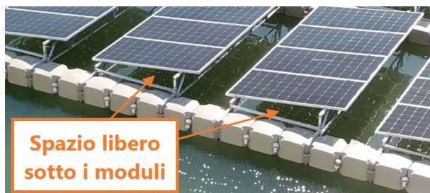
Figura 4 Spazio sottostante i pannelli per agevolazione flusso aria
