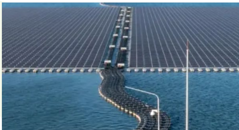
Figura 13 Particolare di cablaggi su passerella galleggiante
