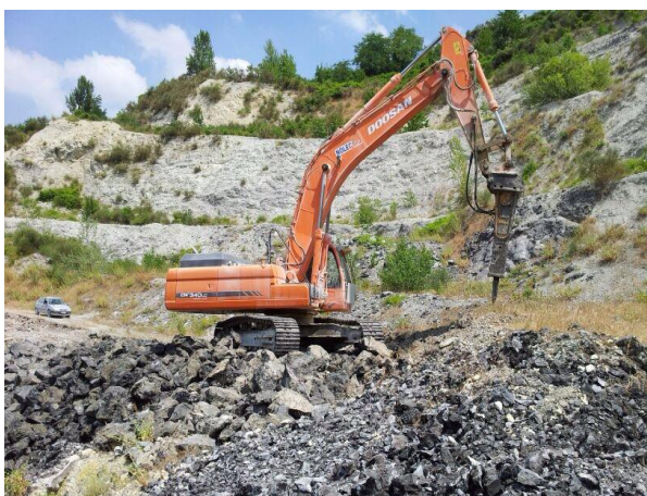
Figura 4 Escavatore martello demolitore
