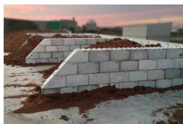
**Figura 11** Esempio di setti separatori in cls del tipo “Qblock” o equivalenti
