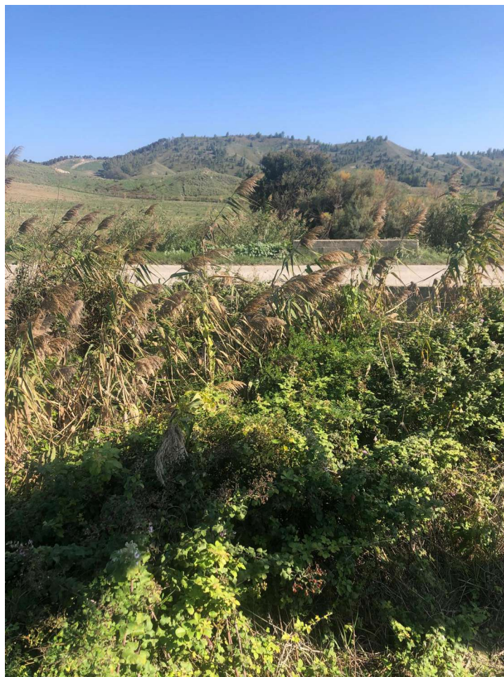
Figura 9 - Foto n.4 – Alveo a valle della vasca in corrispondenza dell'attraversamento della SP 23
