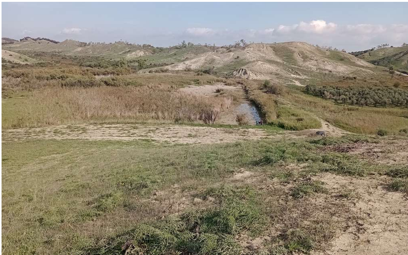
Figura 6 - Foto n.1 – Vista del bacino di accumulo a monte dello sbarramento della vasca
