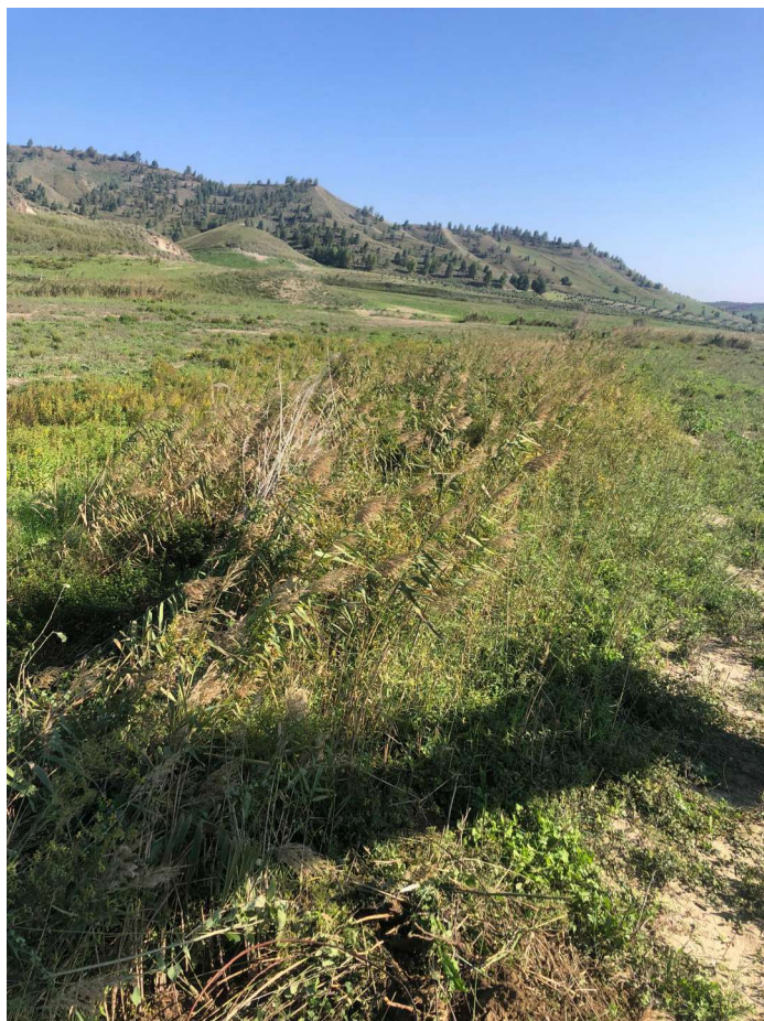
Figura 11 - Foto n.6 - Alveo a valle della vasca completamente ostruito dalla vegetazione
