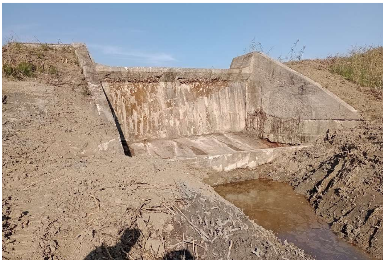
Figura 7 - Foto n.2 – Manufatto di sfioro della vasca
