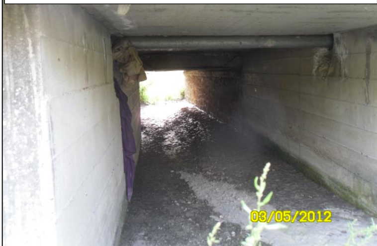
Attrav. C2/T1 lungo S.S. 106 – parte in c.a. e parte in pietra
