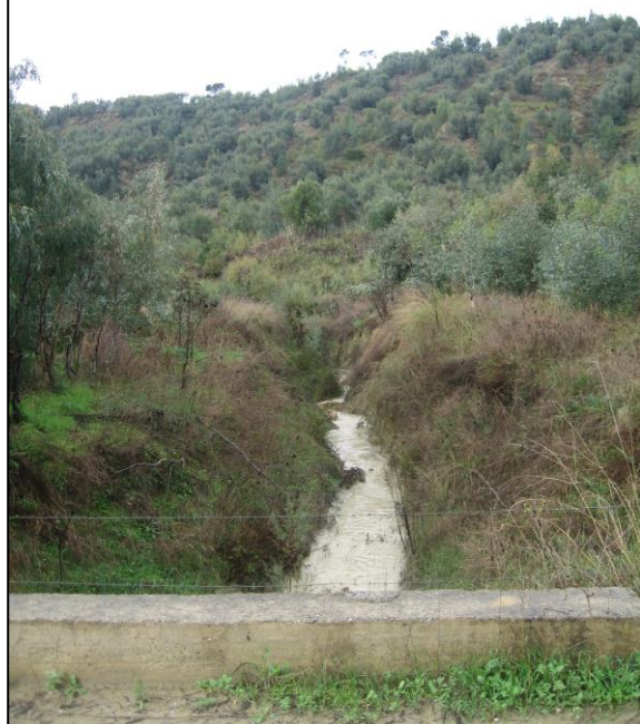
Canale a monte del pontino C1/T1
