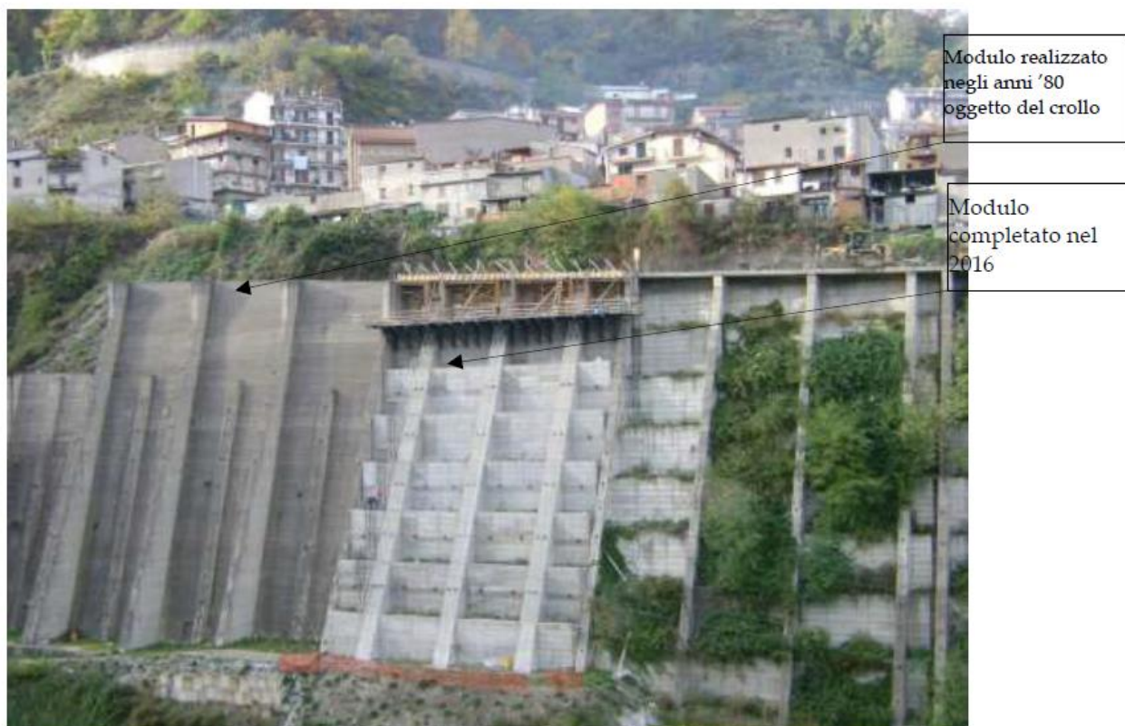
Figura 1. Serie di interventi (prima del crollo) a protezione del centro abitato per 180 ml
