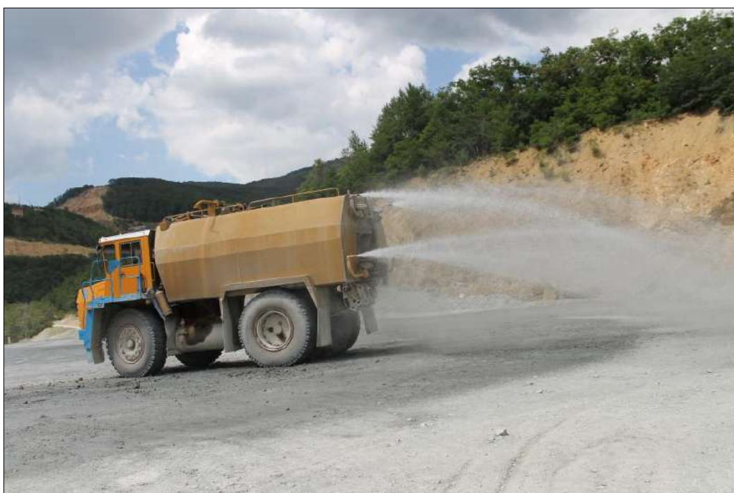
Fig. 24: Bagnatura piste di cantiere per abbattere le emissioni polverose
