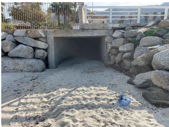
Figura 12 – Canalone scatolare in c.a.
