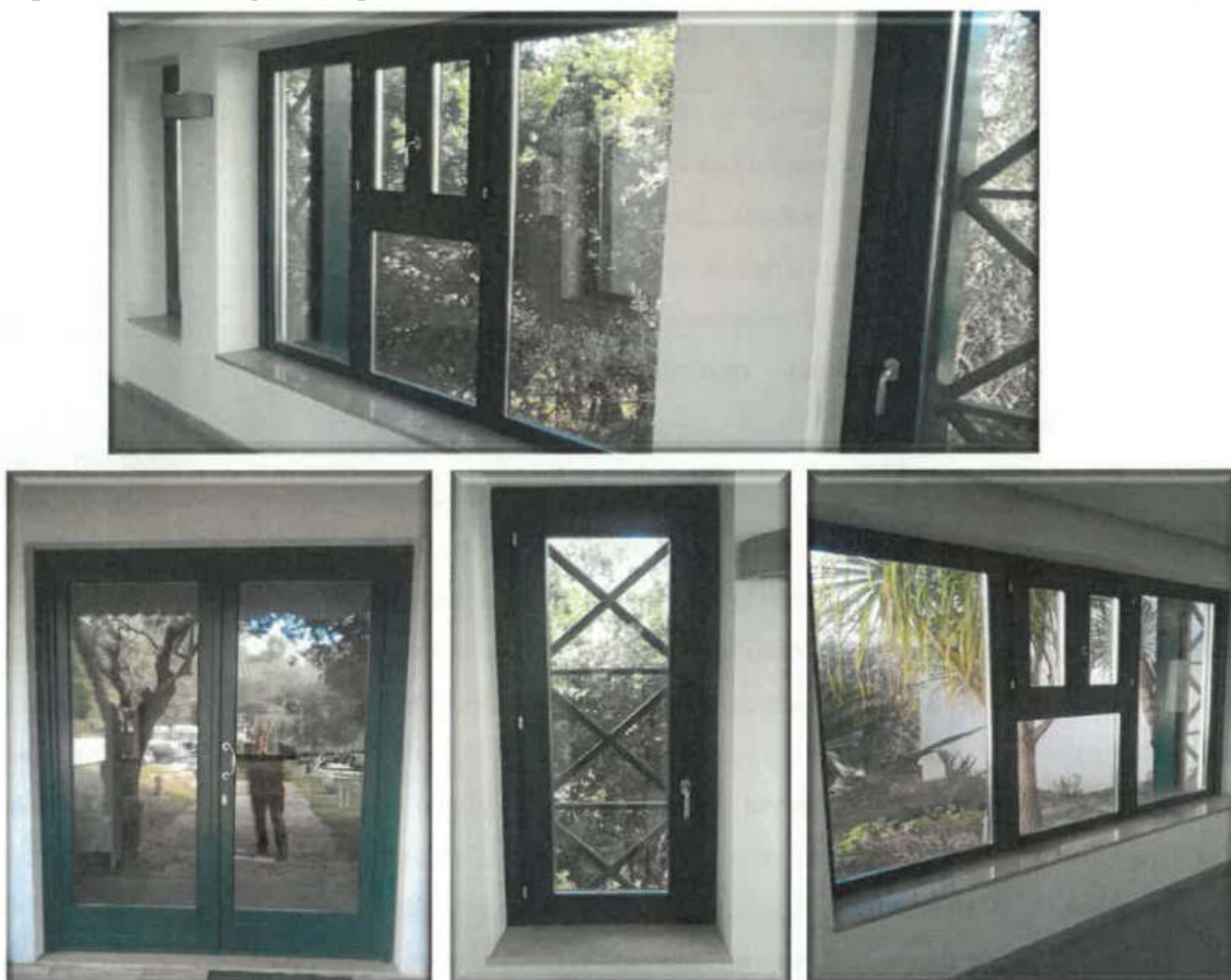
Figura 7 – Nuovi Infissi e Porte-finestre installati negli uffici della Sovreco
