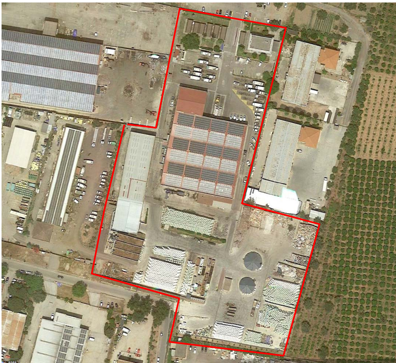
Fig. 2: Ortofoto con ubicazione sito ECOROSS S.r.l.
