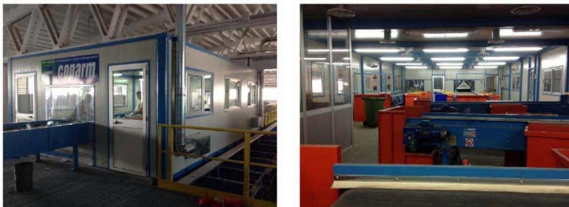
Fig. 44: Fotografia cabina selezione manuale
