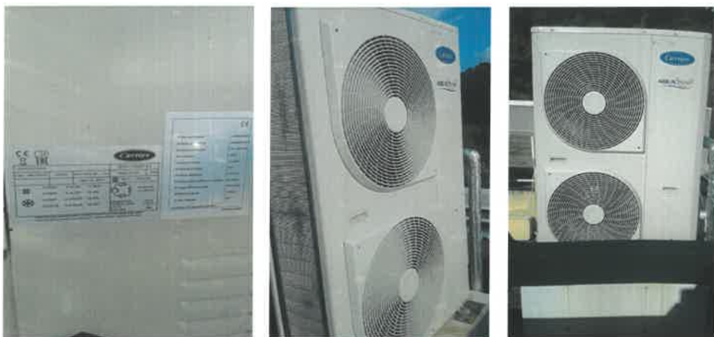
Figura 11 – Etichetta nuove macchine frigorifere Carrier e loro posizionamento
