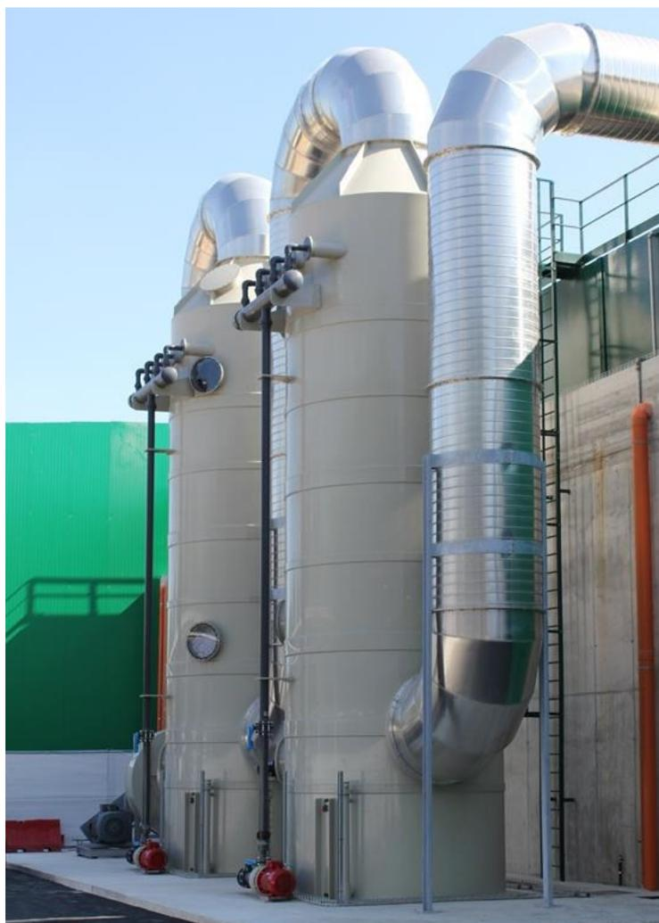
*Figura 15: Esempio di Wet Scrubber*
