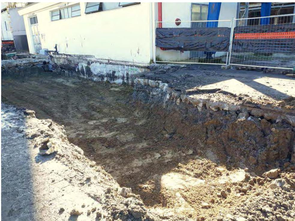
**Figura 2:** scavo risultante dalla rimozione del terreno contaminato, con evidenza della presenza di fondazioni in CLS in corrispondenza di alcune pareti dello scavo
