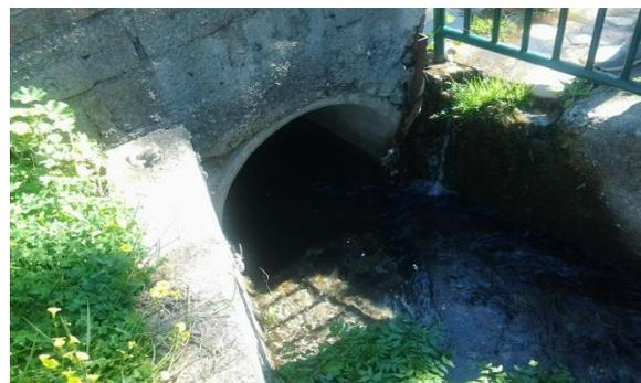
*Figura 3-5 Collettore di raccordo a canale tombato sotto Viale Ionio*
