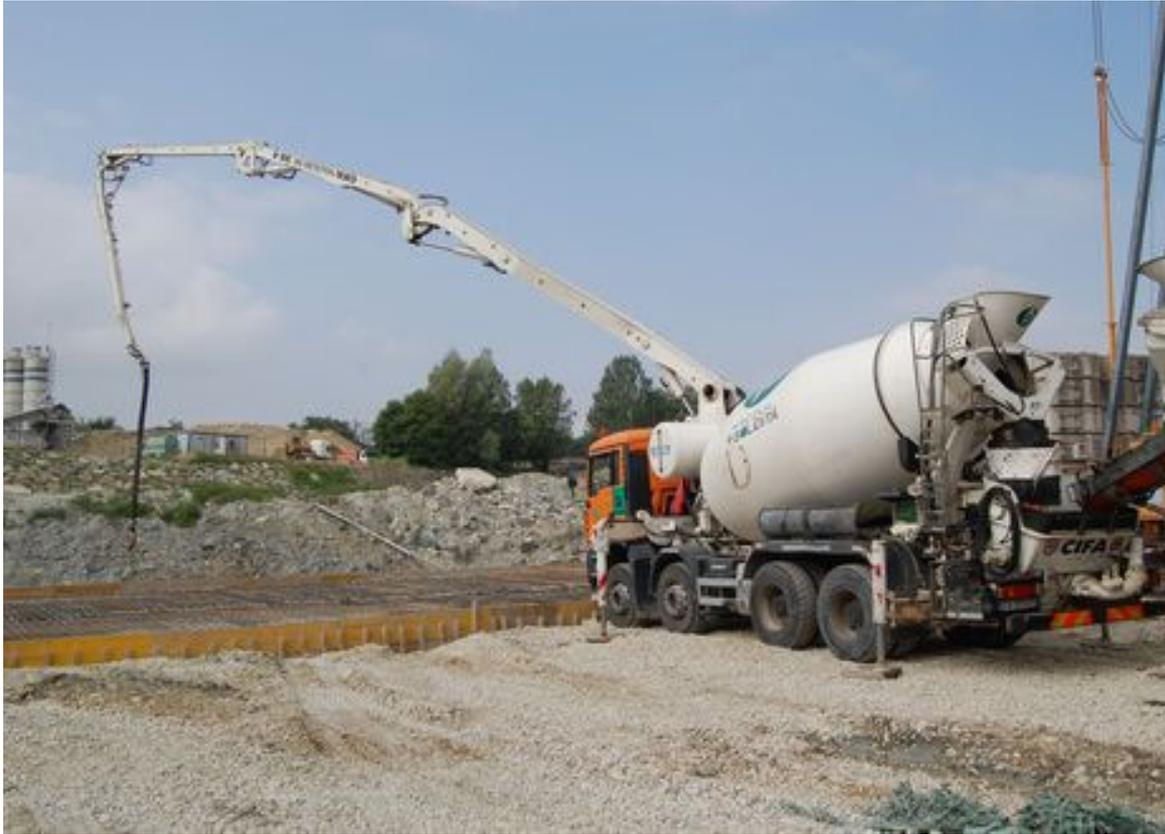
Figura 48: Esempio di getto di calcestruzzo con autobetoniera munita di pompa
