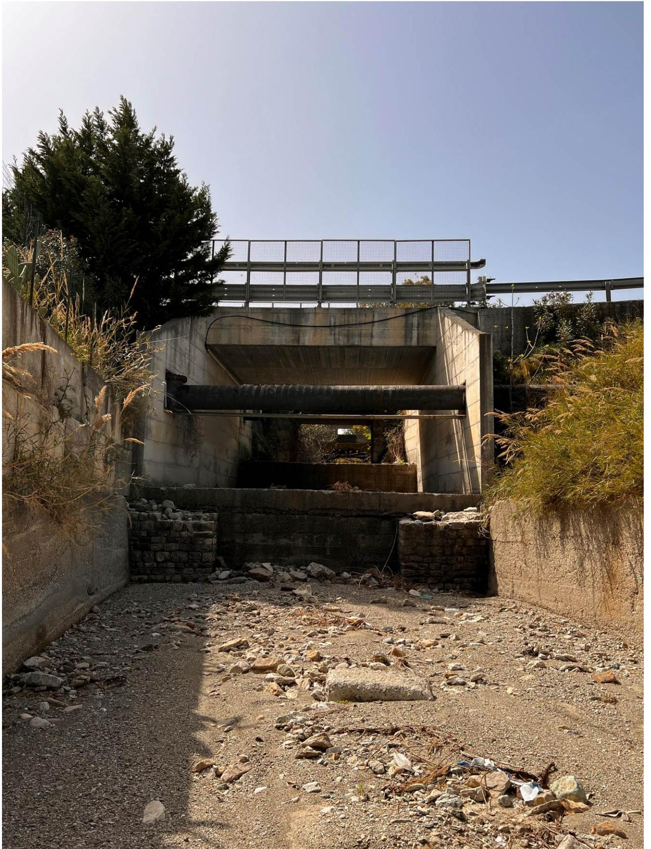
Figura 10: Vista da valle del ponte della strada comunale, delle ferrovie e della SS106 con presenza di salti e fognatura
