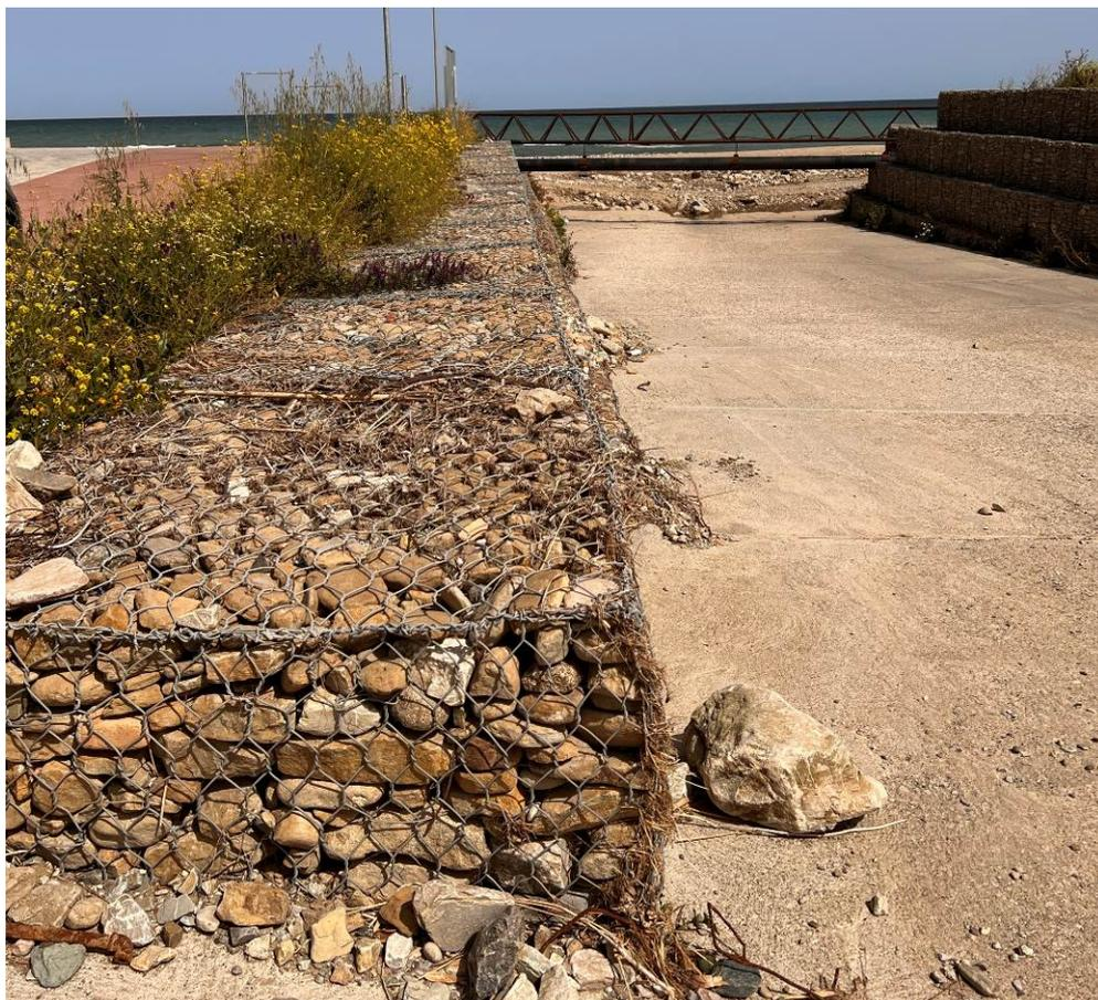
Figura 6: Vista della parte terminale del corso d'acqua sistemato con gabbioni e cementificazione del fondo
