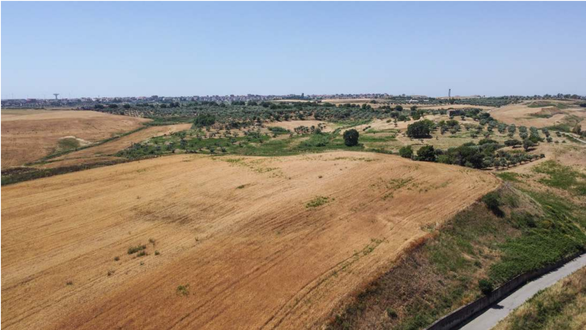
Fig.37 Foto aerea da drone stato di fatto (h=40m) - Punto di scatto pressì Aerogeneratore S4
