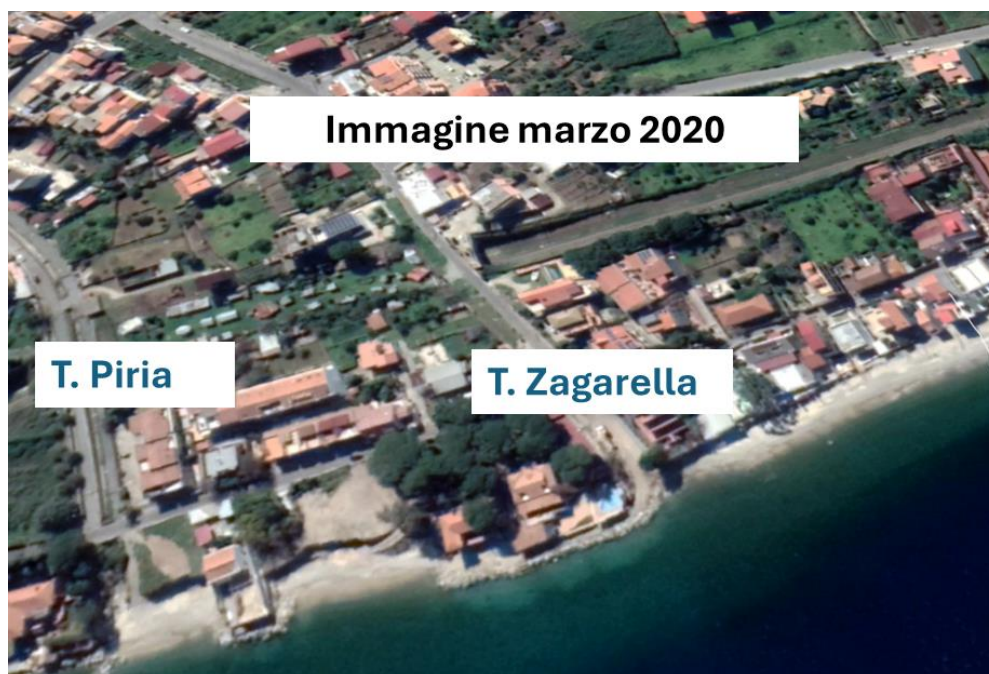
Fig. 2 Tratto di interesse tra i Torrenti Piria e Zagarella a marzo 2020 e dopo la realizzazione delle opere nel tratto precedente
