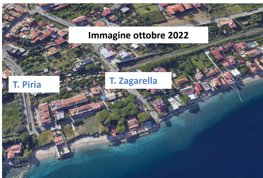
Fig. 3 Tratto di interesse tra i Torrenti Piria e Zagarella a ottobre 2022 e dopo la realizzazione delle opere nel tratto precedente
