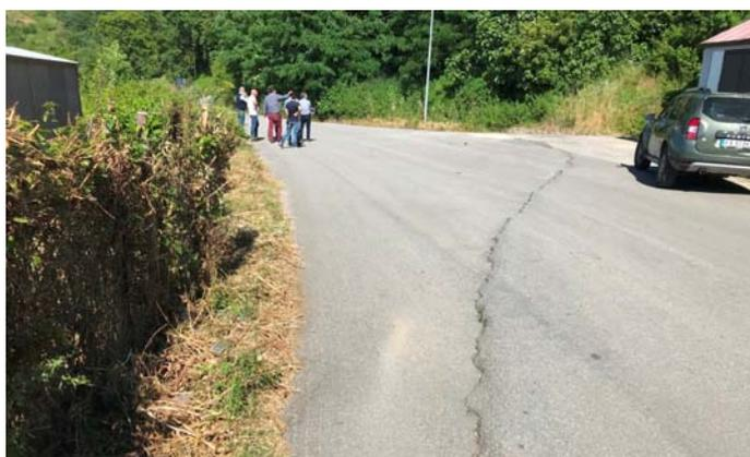
**Figura 2.2 - Frattura sulla SP47 nel tratto di attraversamento del T. Fallà**
