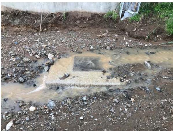
**Figura 2.6 - Pozzetto condotta di scarico a mare depuratore interrato nell'alveo (a valle SS522)**
