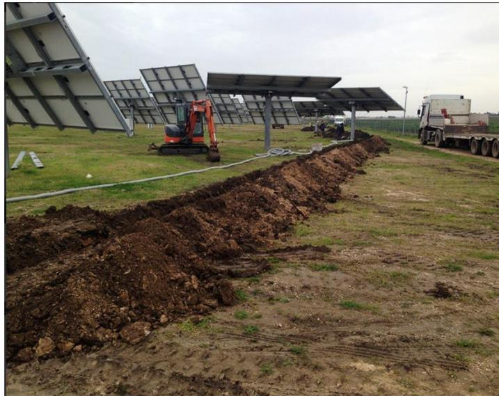
*Figura 22 - Esempio della fase di scavo trincee*
