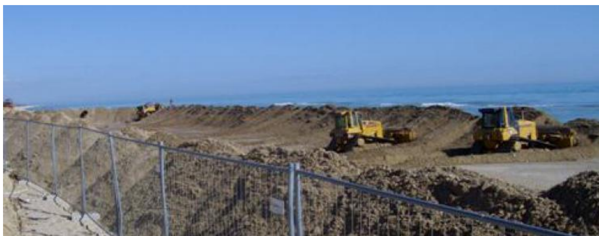
Figure 15: Esempio di modellazione della spiaggia con pale meccaniche a seguito di deposizione meccanica
