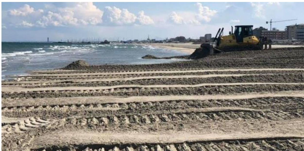
Figura 23: Esempio di stendimento della sabbia sulla spiaggia post pompaggio
