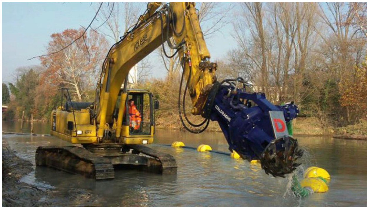
Figura 22: Pompa dragante montata su pala meccanica
