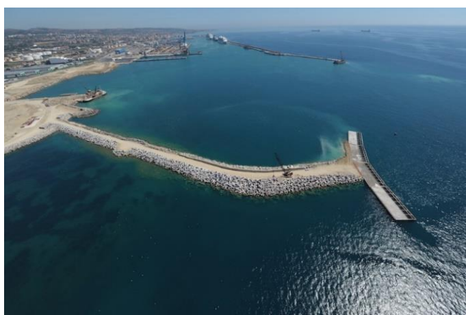
Figura 4-14. Porto di Civitavecchia (RM), applicazione del sistema OWC denominato REWEC3 dotato di una particolare turbina di tipo Wells prodotta dalla società Faggiolati.
