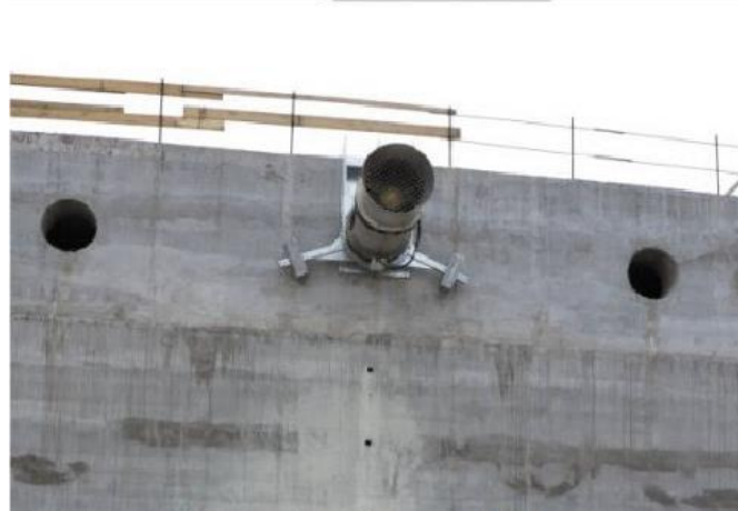
Figura 4-14. Porto di Civitavecchia (RM), applicazione del sistema OWC denominato REWEC3 dotato di una particolare turbina di tipo Wells prodotta dalla società Faggiolati.
