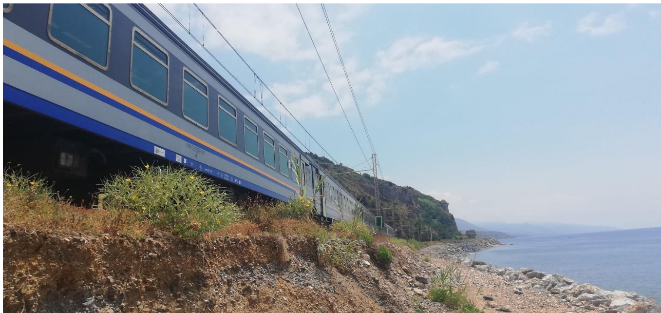
Figura 3-1. Visuale linea ferroviaria dall'area di intervento
