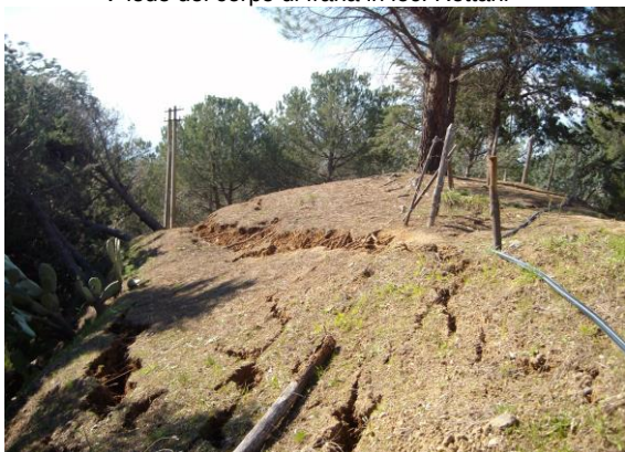
Piede del corpo di frana in loc. Rottani
