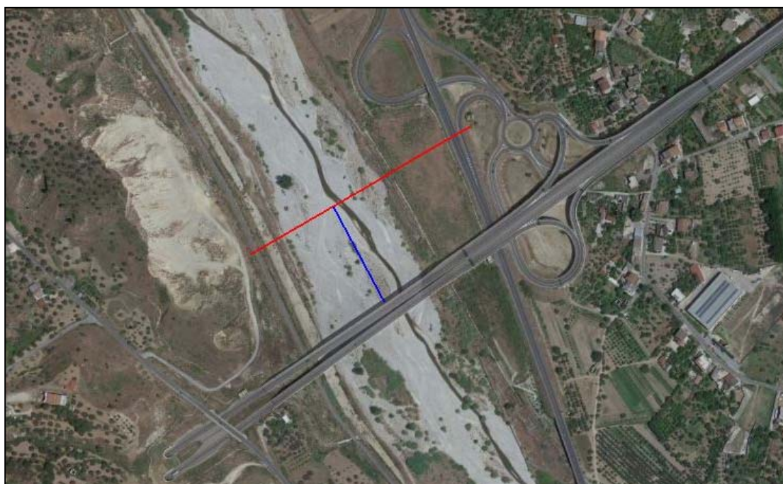
Sezione 10 - distanza dal viadotto 150m
