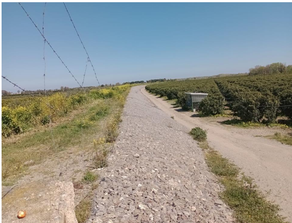
Figura 3 - Argine rinforzato (interventi 2015-16) e coltivazioni agricole intensive (agrumeti) all'interno dell'alveo- Vista da monte verso valle al km 4,8 dalla foce
