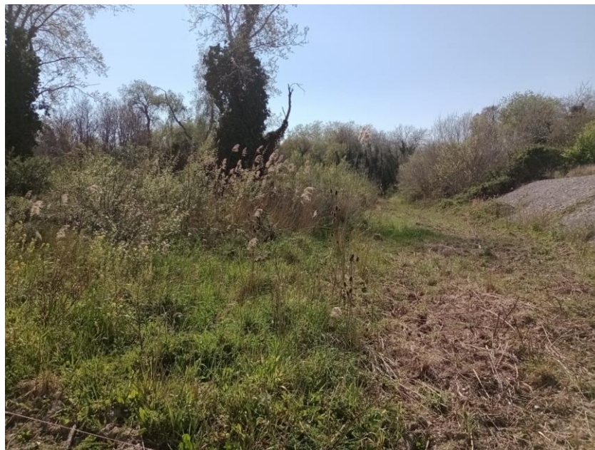
Figura 6 – Fine Argine rinforzato (interventi 2015-16) ed inizio tratto di folta vegetazione fino al ponte della linea ferroviaria - Vista da valle
