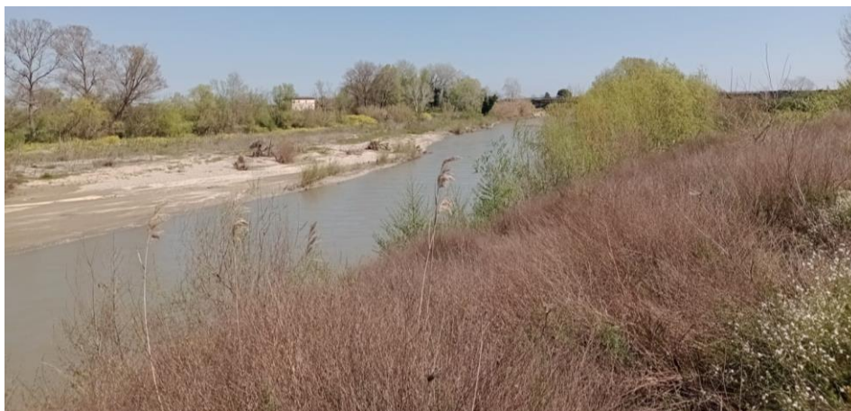
Figura 24-25-26 - Tratto con massicciata in massi intervento 2019 coperto da vegetazione
