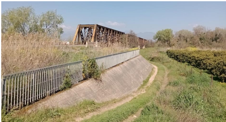
Figura 14 – Ponte ferroviario. Argine e Terreni coltivati in alveo. Vista dall'argine verso il fiume
