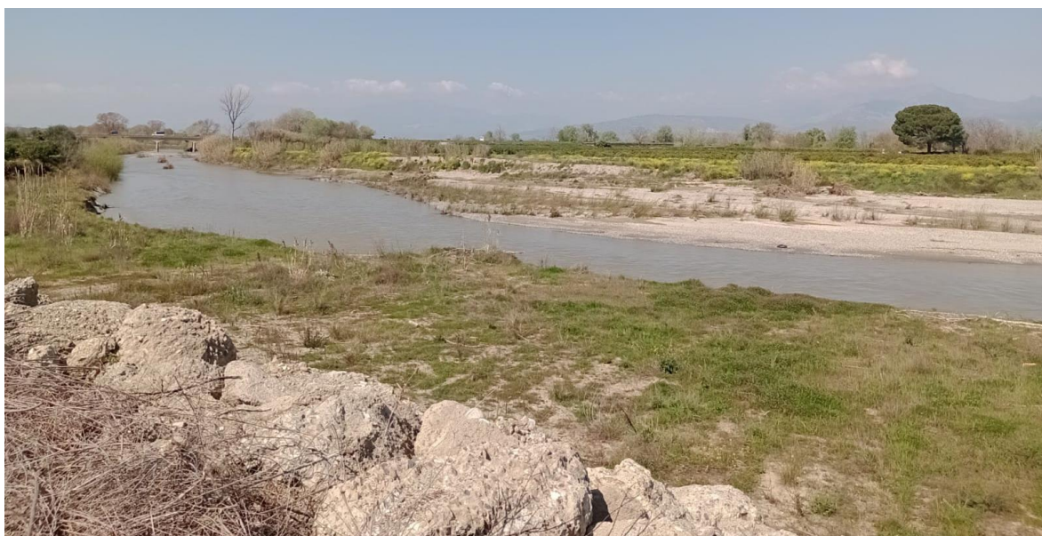
Figura 19 – Punto di rottura d'argine 23 novembre 2018 e Intervento di emergenza ed Intervento 2019. Vista verso il fiume.
