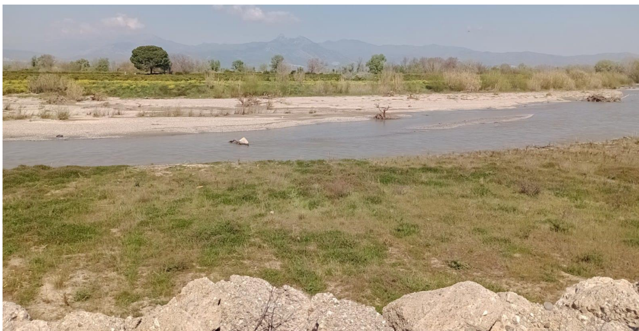
Figura 21 – Punto di rottura d'argine 23 novembre 2018 e Intervento di emergenza ed Intervento 2019. Vista verso la sponda sx
