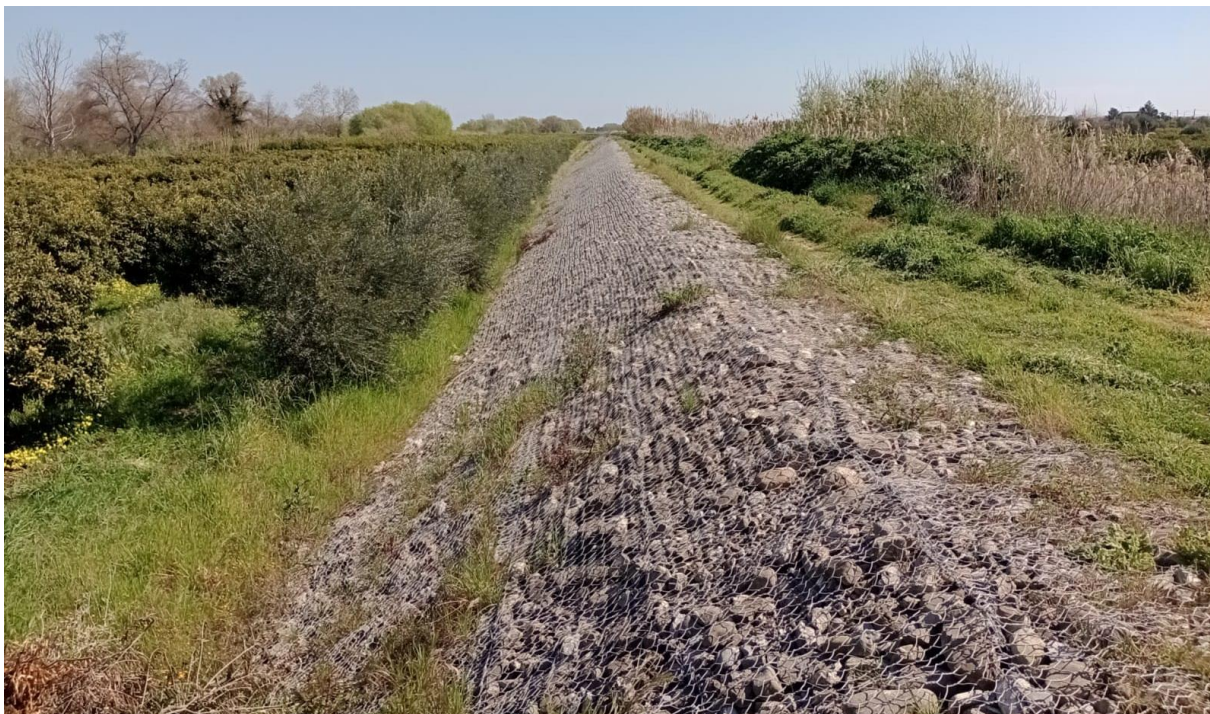
Figura 15 – A valle ponte ferroviario. Argine rafforzato con Interventi 2015-16 e Terreni coltivati in alveo. Vista da monte verso valle
