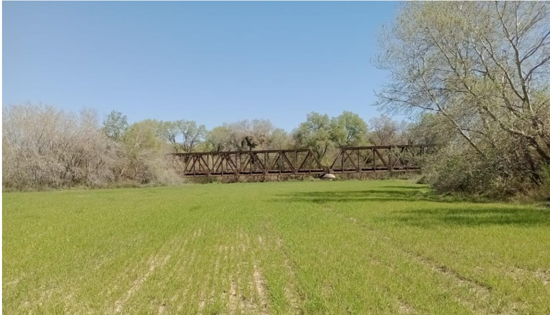
Figura 10 – A monte ponte ferroviario. Terreni coltivati.- Vista da monte verso valle (in sx argine ed in dx alveo di magra delimitato da alberature di alto fusto)
