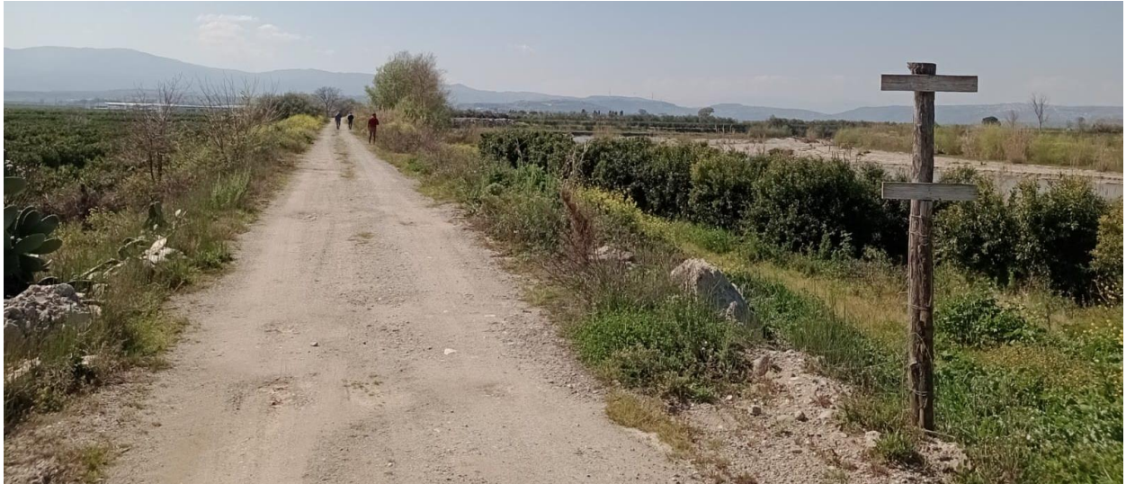
Figura 16 – A monte ponte ferroviario. Argine e Terreni coltivati in alveo. Vista da valle verso monte
