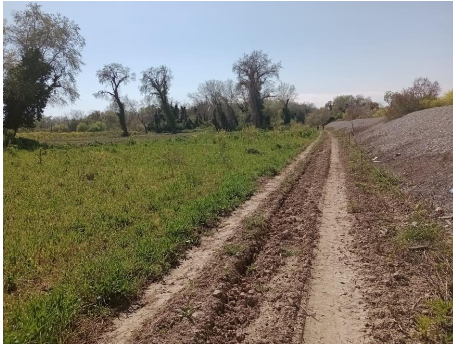
Figura 5 - Argine rinforzato (interventi 2015-16) - Vista da valle
