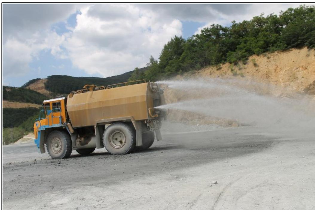
Figura 18: Bagnatura piste di cantiere per abbattere le emissioni polverose
