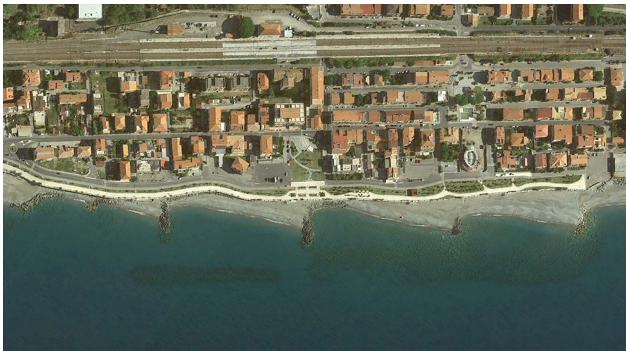
fig. 11 – Stato dei luoghi ante operam
