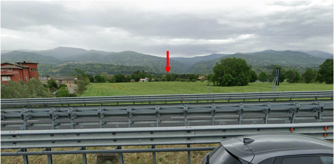
Punto di vista D (area da schermare con opportune misure di mitigazione)
