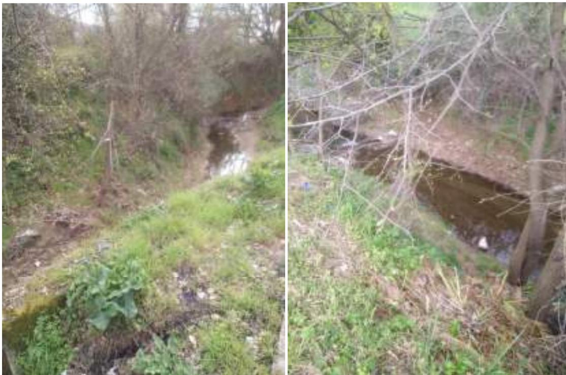
Figura 10 – Tratti di canale caratterizzati dalla insufficienza della sezione disponibile per il deflusso idraulico e con sponde in terreno naturale con notevole pendenza e per ciò non sicure
