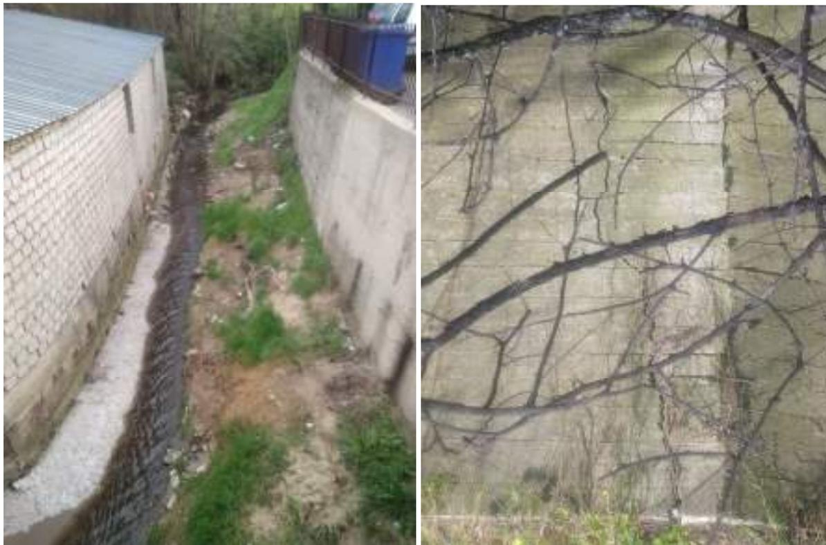
Figura 8 – Particolare del tratto di rio delimitato dal muro in c.a. del parcheggio e un edificio privato e dettaglio della parte di muro danneggiato
