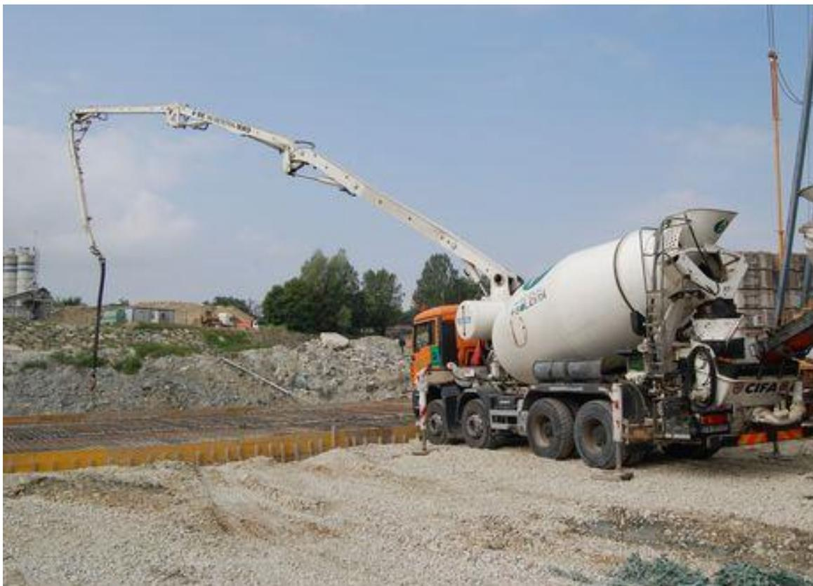
Figura 35: Esempio di getto di calcestruzzo con autobetoniera munita di pompa
