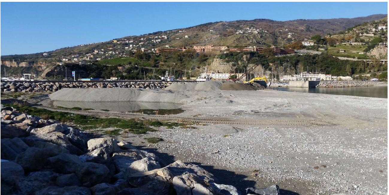
Figura 2-7 Accumulo del materiale dragato
