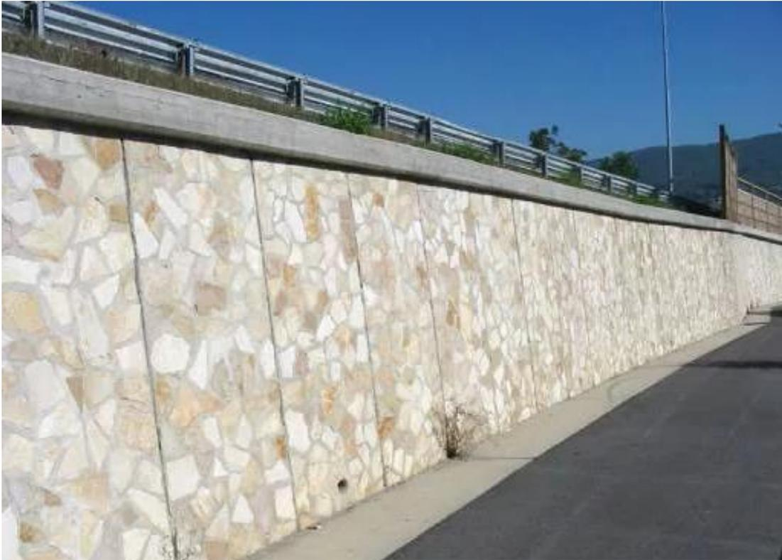
*Figura 27 Rivestimento in lastre di pietra per il rivestimento dell'attraversamento*
