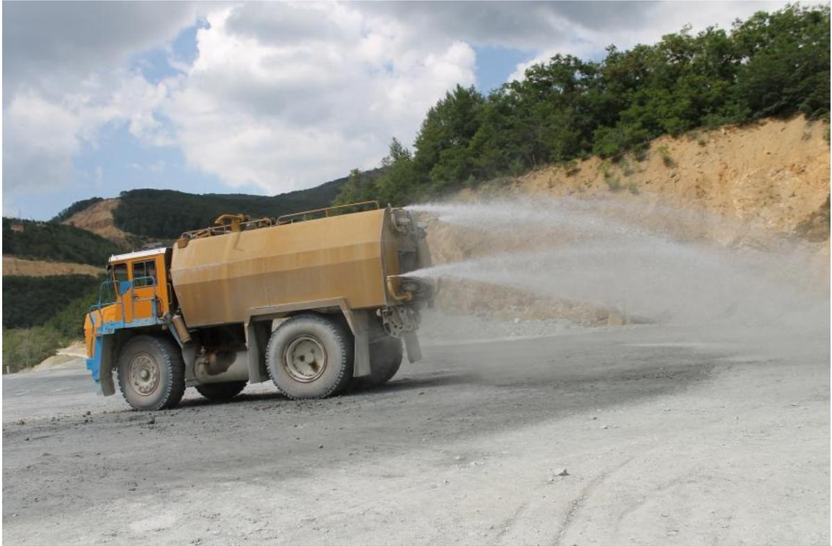
*Figura 25 Bagnatura piste di cantiere per abbattere le emissioni polverose*
