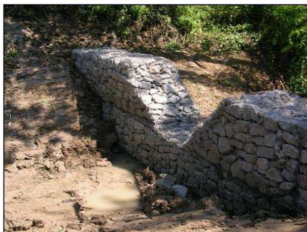
strutture armate, flessibili, drenanti, possono rivelarsi di lunga durata, e consentono inoltre di limitare l'impatto delle strutture sull'ambiente, visto che si ritrovano in favorevole sintonia col paesaggio.
