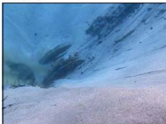
Flangia, e perdita, del tubo a 105mt
