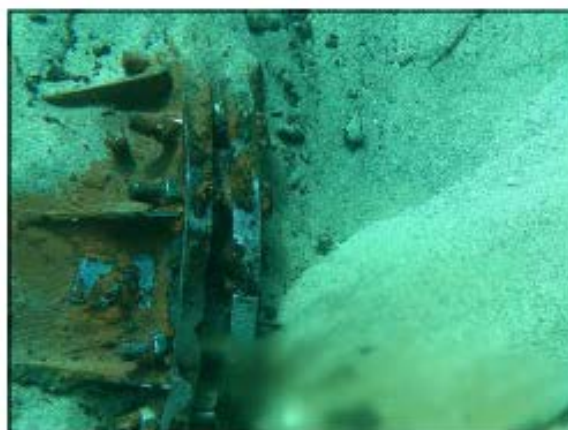
Flangia, e perdita, del tubo a 105mt
