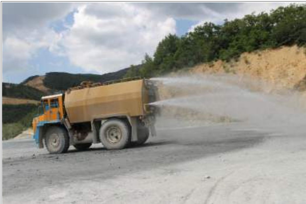
Figura 26: Bagnatura piste di cantiere per abbattere le emissioni polverose
