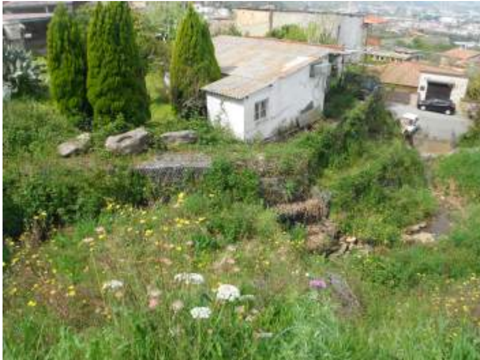
Figura 7 Vista gabbioni tratto 3 – da via Roma
