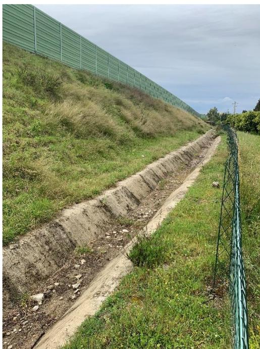
Figura 26 Canaletta di intercetto acque di scarpata strada statale Jonica
