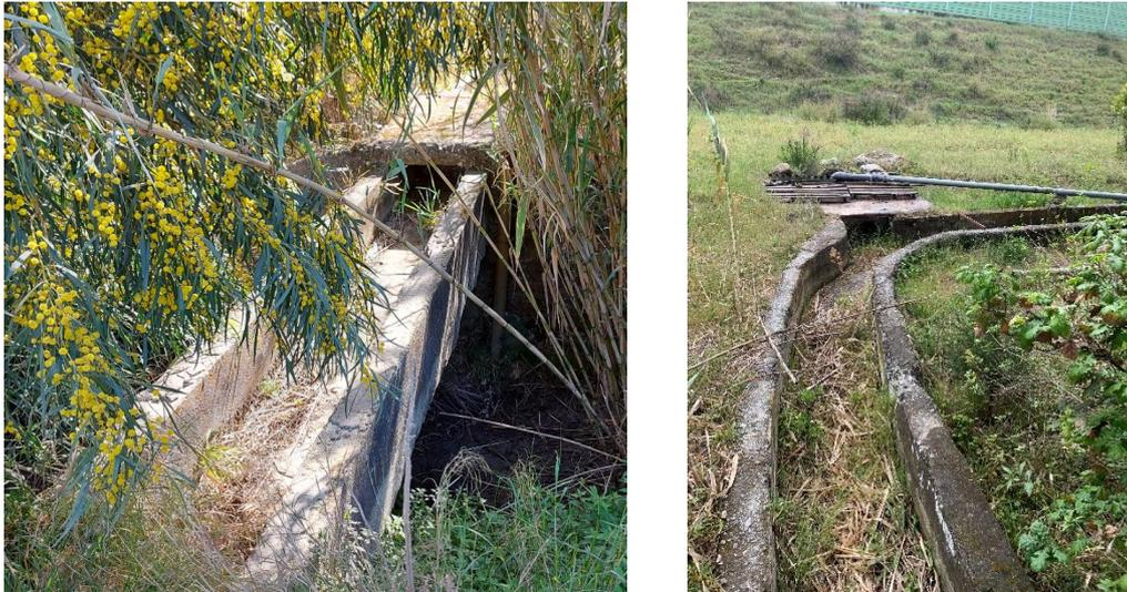
Figura 18 Dettaglio attraversamento canale B e deflusso in cassa di espansione canale B
