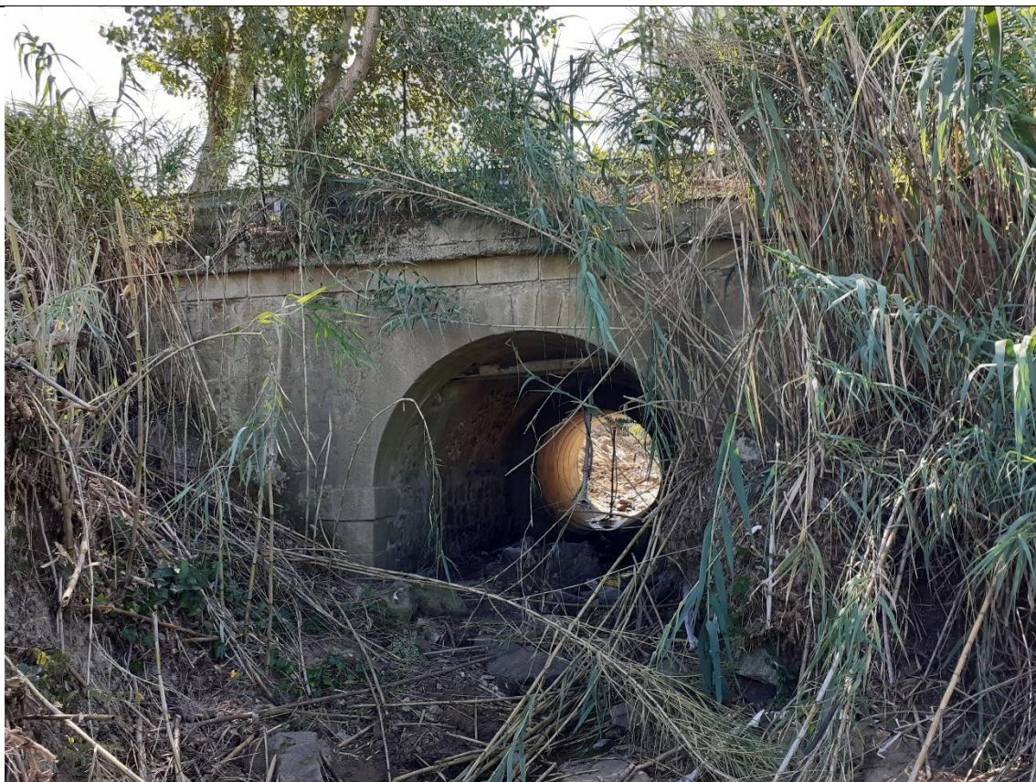
Figura 7. Ponte di via Iclea sull'affluente destro del torrente.
