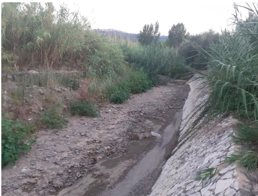
Figura 4. Sponda destra rivestita in pietra e sinistra in gabbioni, poco a valle della sezione 14.
