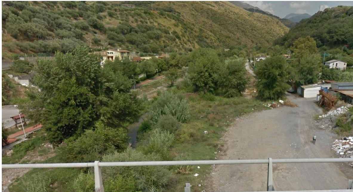
Figure 13 - Vista dell'area omogenea 4 dalla S.S.18
