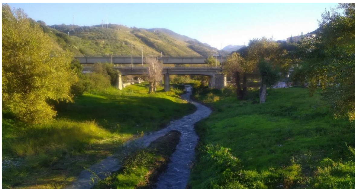
Figure 11 - Vista del tratto omogeneo 3 dal ponte di Via Mattia Preti
