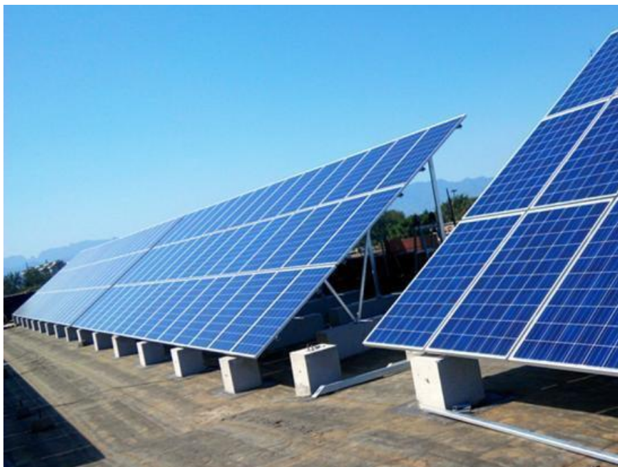
Figura 4.1.6 – Esempio di impianto fotovoltaico con fondazioni formate da zavorre costituite da plinti in cemento.
