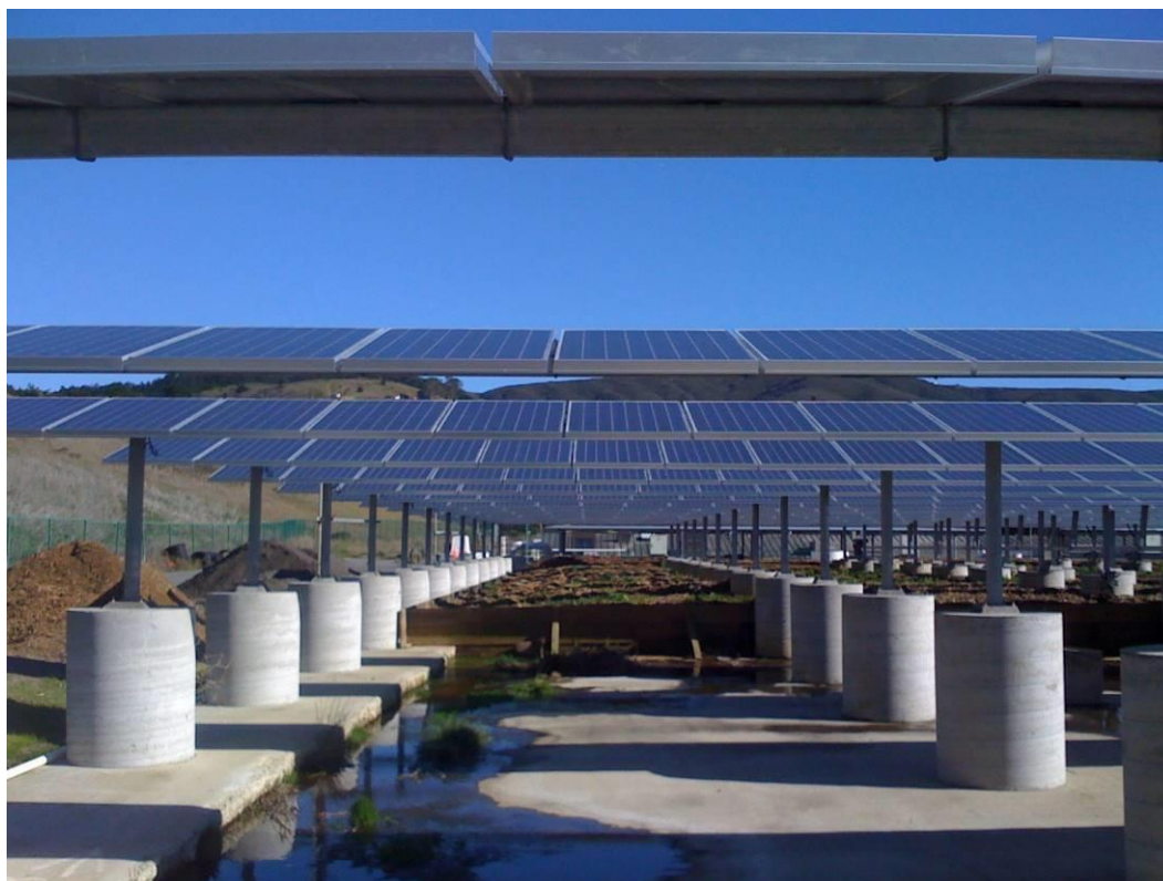
Figura 4.1.5 – Esempio di impianto fotovoltaico con fondazioni formate da zavorre costituite da plinti in cemento.
