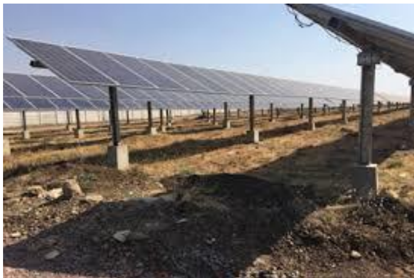
Figura 4.1.4 – Esempio di impianto fotovoltaico con fondazioni ottenute mediante perforazione del terreno e successiva creazione del palo di fondazione con getto di cemento.
