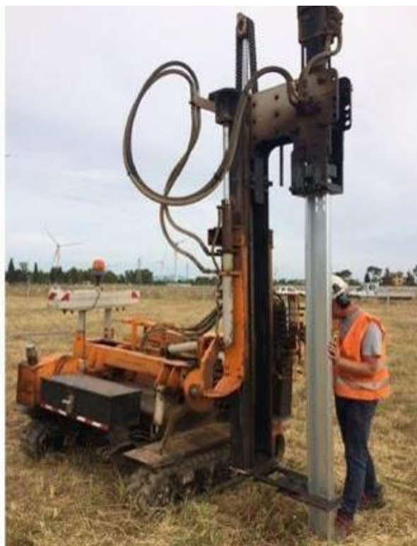
Figura 4.1.1 – Esempio di supporto costituito da palo in acciaio infisso direttamente nel terreno mediante battipalo.
